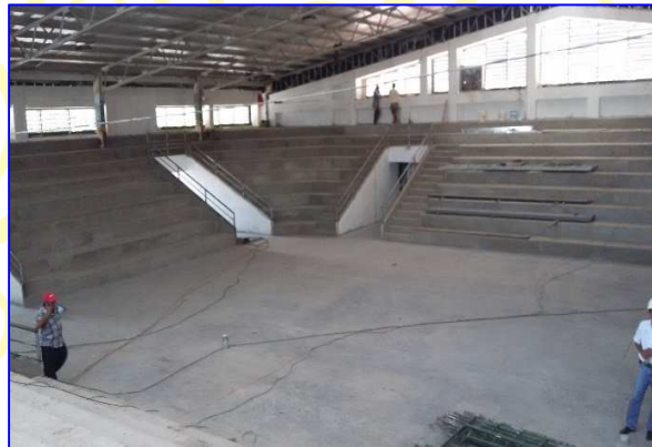
Vista interna del área graderías donde se observa la finalización de construcción de losa de concreto reforzado en área del cuadrilátero y pasillos de accesos.
